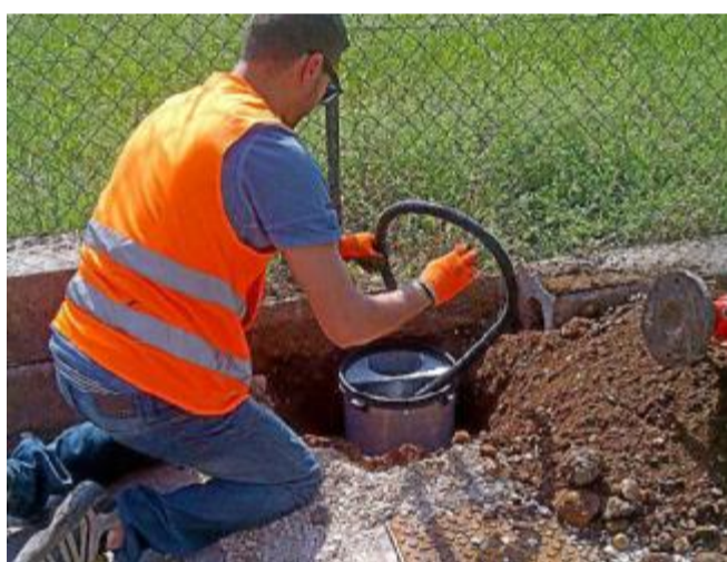
La posa di un lampione con la tecnologia innovativa di Atlantech
